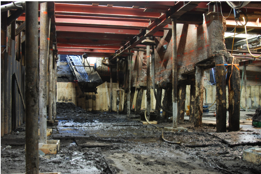
8 De geheel ontgraven kelderruimtes van Herengracht 74 (links) en 76 (rechts), gezien richting straat
